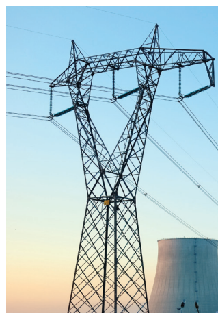
Actualmente la producción de energía eléctrica tiene gran impacto ambiental.
