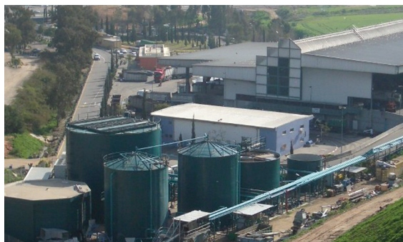
Digestores anaeróbicos, Tel Aviv, Israel.
