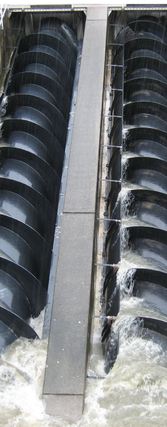
El tornillo de Arquímedes todavía se emplea para mover agua.
